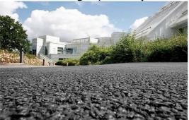
Ecco il TopMix Permeable, un materiale che riesce a trattenere, una volta applicato sul suolo, enormi quantità d'acqua in una manciata di secondi
